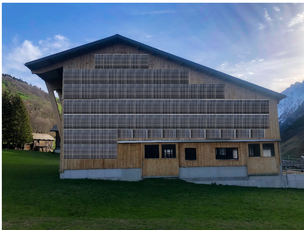
Solaranlage an Südfassaden
