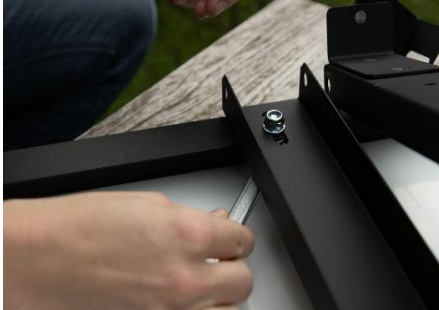
Bild 2: U-Profile an Solarmodul befestigen
