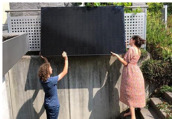
Bild 8: Modul ans Geländer hängen
