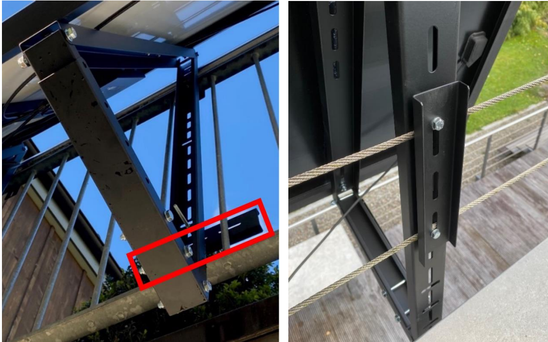
Bild 9: Horizontale oder vertikale Befestigung der Sicherheitsplatte
