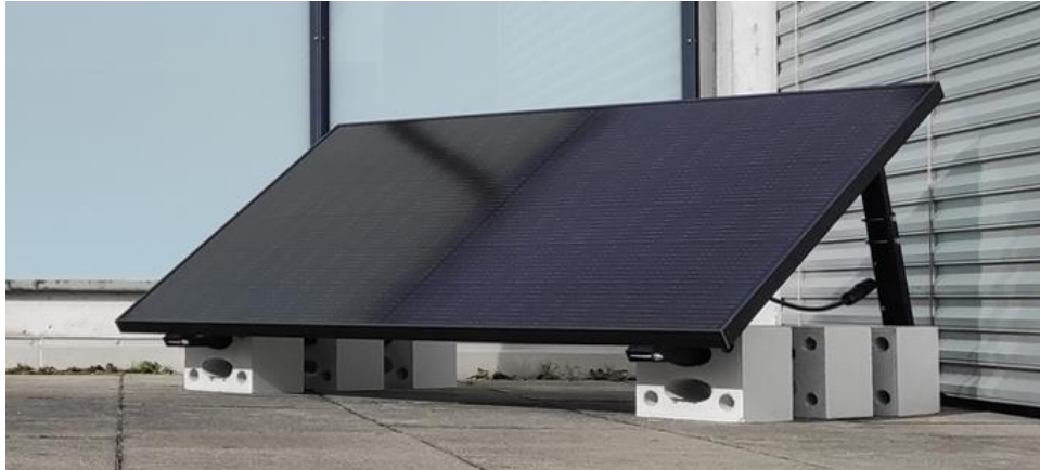
Bild 11: Montage mit Sockelsteinen
